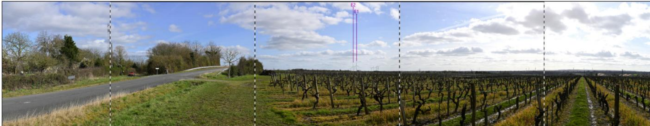
5 - PHOTOSIMULATION - (O Eolienne en service, O Eolienne accordée, O Eolienne en construction, O Projet éolien de Saint-Paul-du-Bois) - VUE PANORAMIQUE 180°
